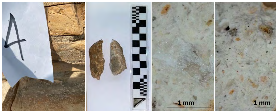
Zona de extracción de la muestra 4 y diferentes aspectos del mortero visto con lupa donde se aprecia un cristal de yeso superior al milímetro y abundantes finos de cerámica triturada.
