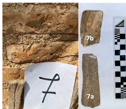
Zona de extracción de las muestras 7a (mortero) y 7b (ladrillo).
